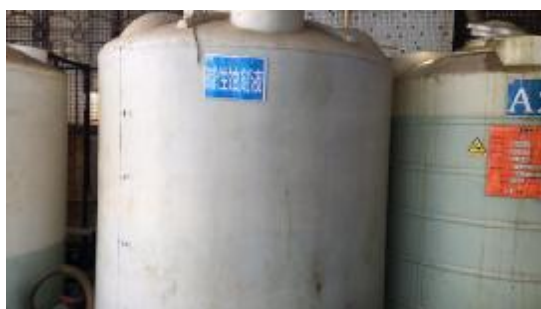
氨水储罐标识
